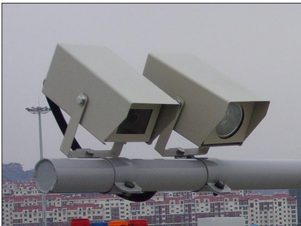
图 3.5 相机和闪光灯的安裝
