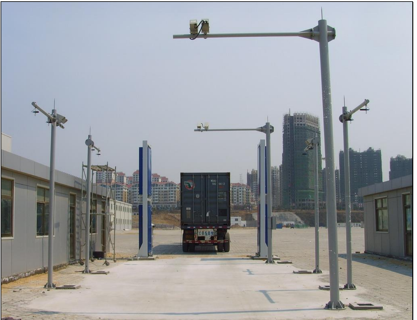
图 3.9 室外设备安装连接完成后的状态
