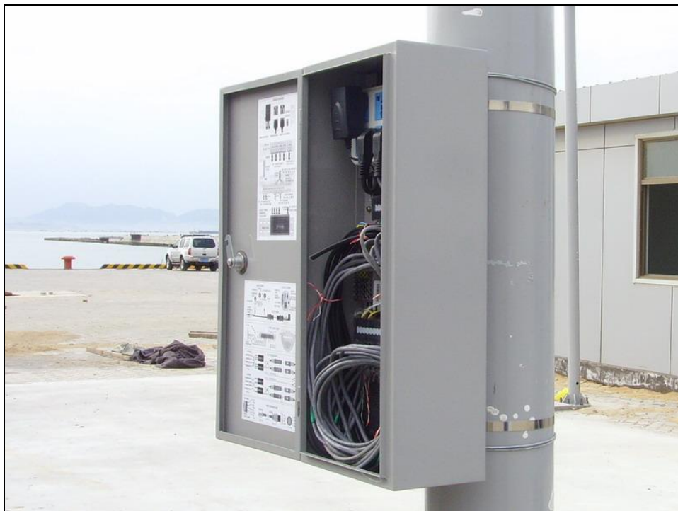
图 3.4 控制箱的安装
